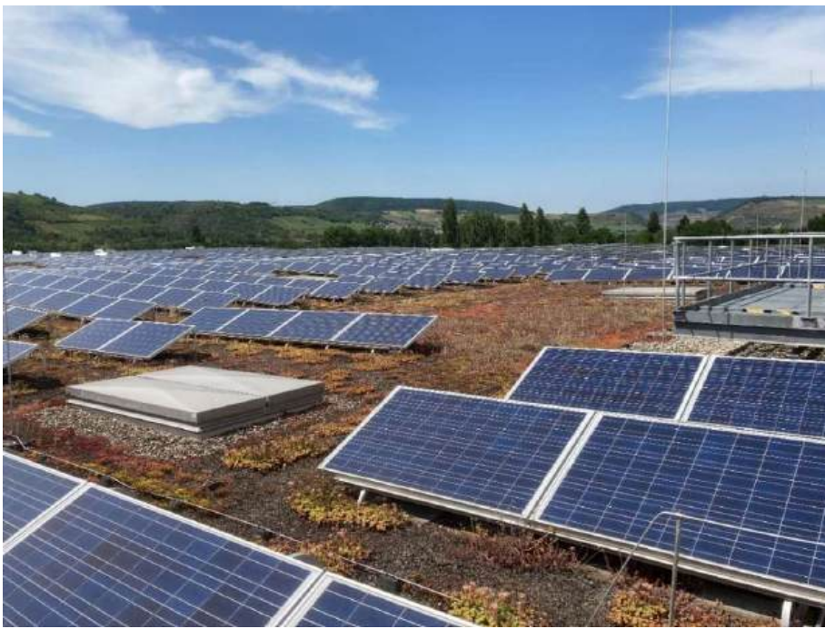
Foto 1: Beispielhafte Darstellung einer extensiven Dachbegrünung in Kombination mit PV-Anlagen (Fotoaufnahme: ÖKOPLANA)
